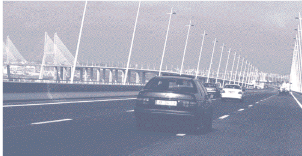
Sur autoroute, le montant des péages acquittés pourrait évoluer avec une tarification plus fine. Le Pont Vasco De Gama sur le Tage (Portugal) – Photo : Groupe Vinci/Francis Vigouroux
