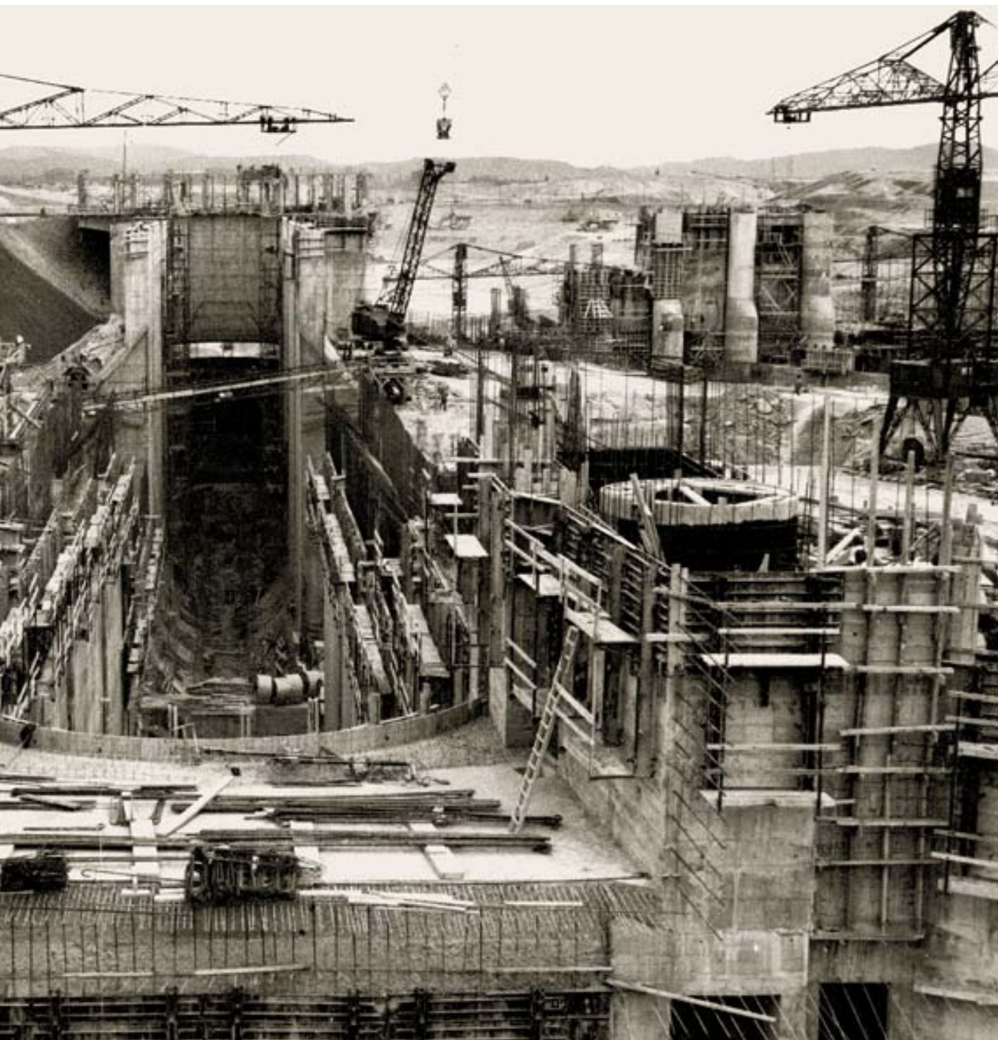
◀ Vue amont de l'écluse en juin 1951
