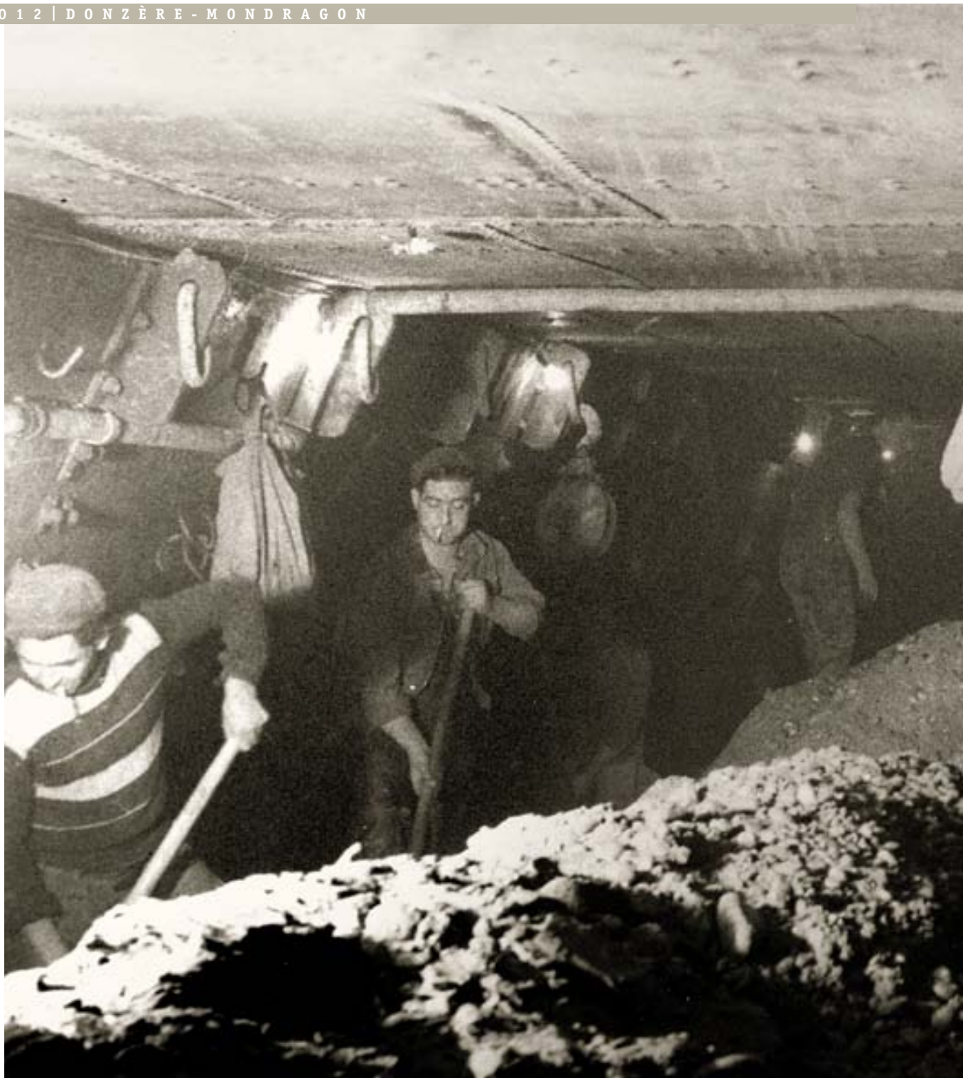
Ouvriers terrassant ▶ à l'intérieur du caisson n°5
