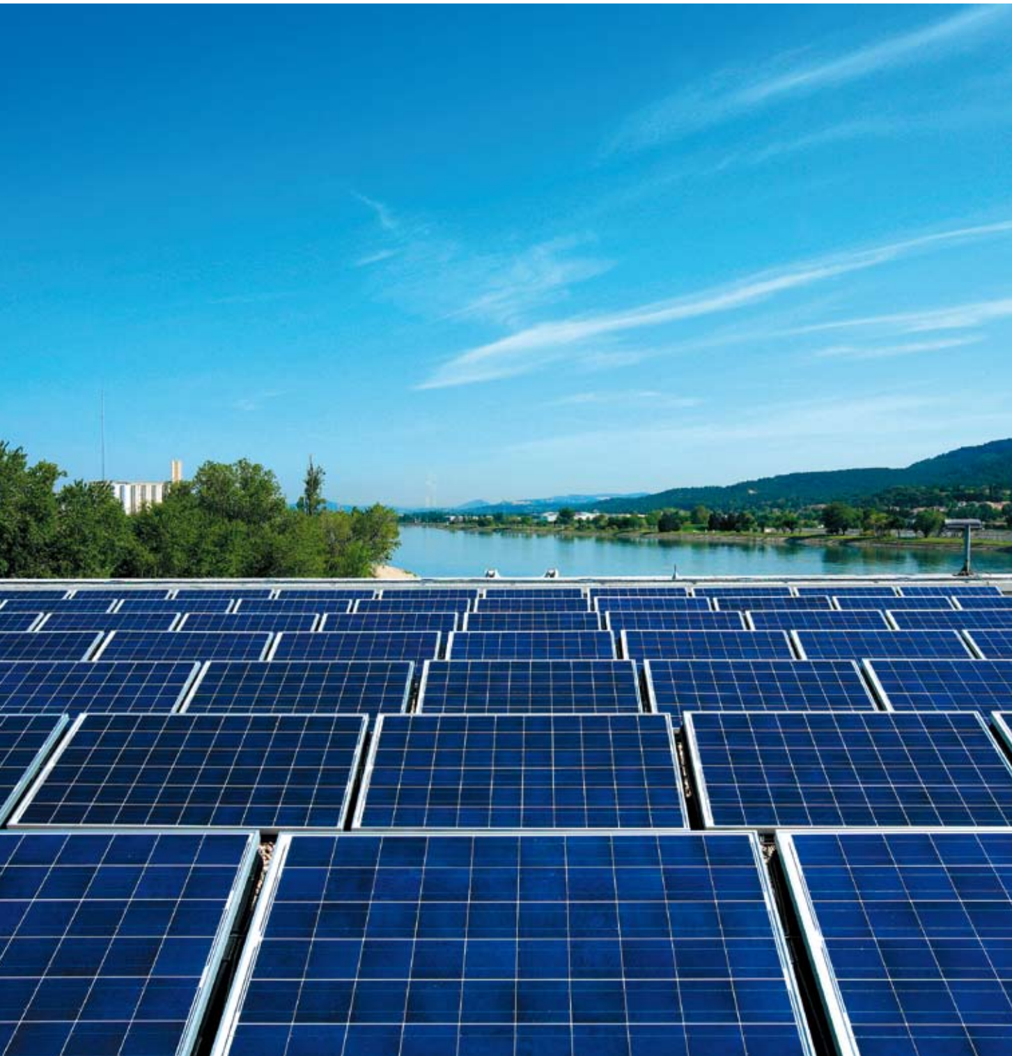
◀ Panneaux solaires sur le toit de la centrale André Blondel
