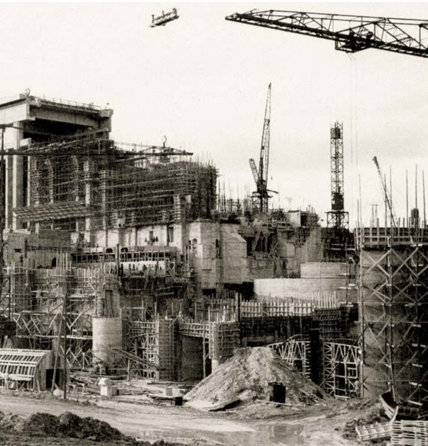
◀ Centrale André Blondel en février 1951
