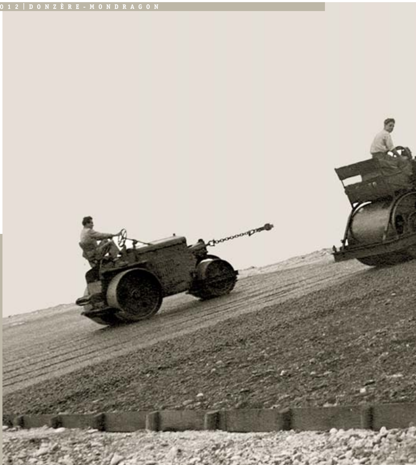
Cylindrage du revêtement bitumineux des berges ▶ bitumineux des berges
