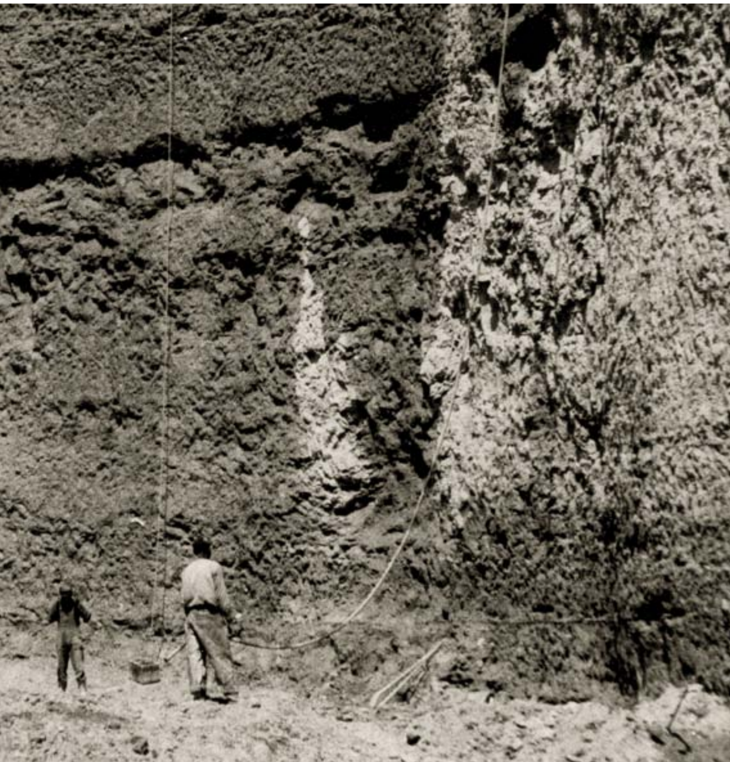
◀ Finition de la paroi de l'écluse
