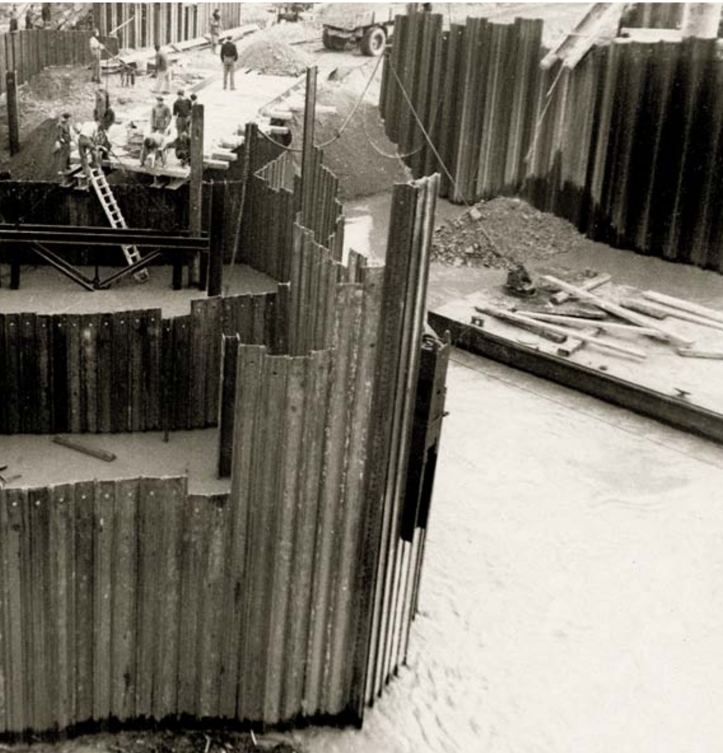
◀ Batardeau amont de la passe 6, remplissage des premières alvéoles
