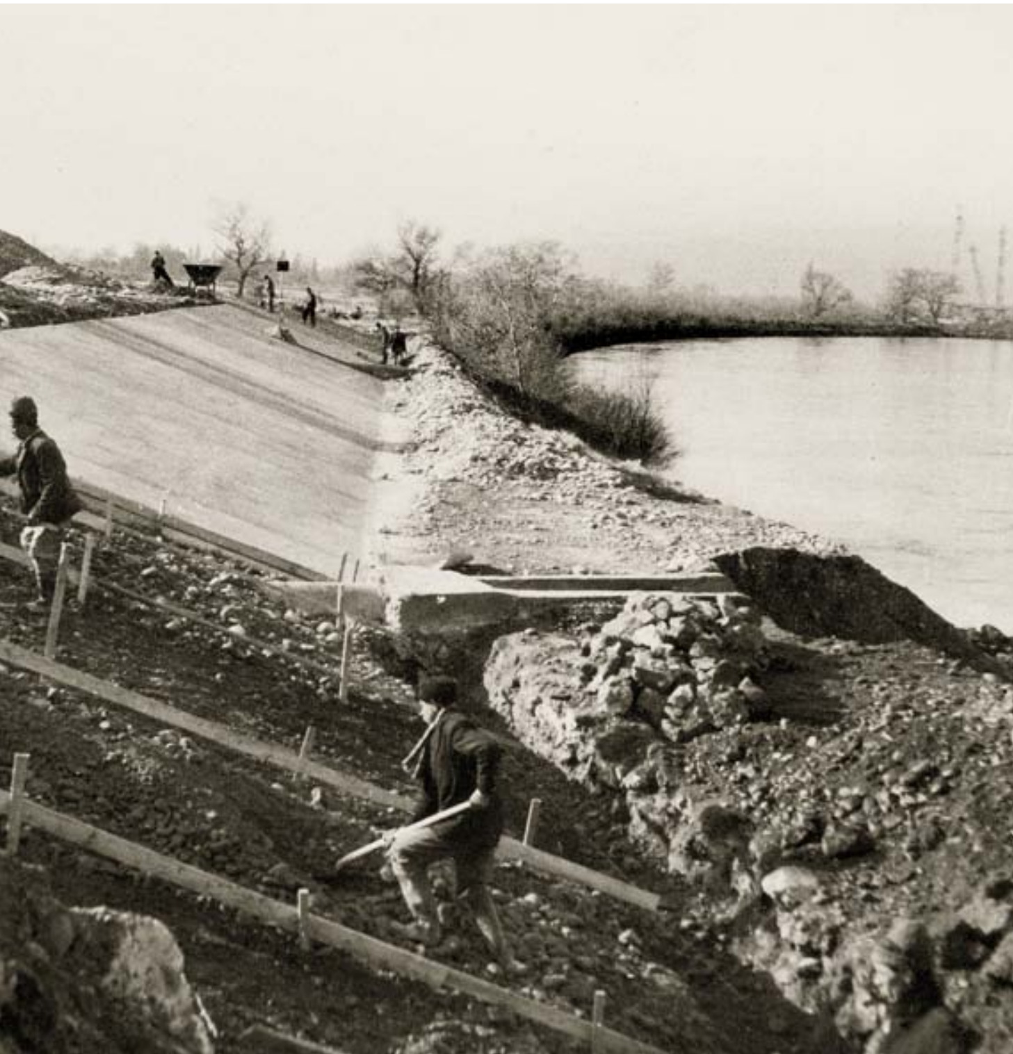
◀ Bétonnage du perré en bordure de Rhône
