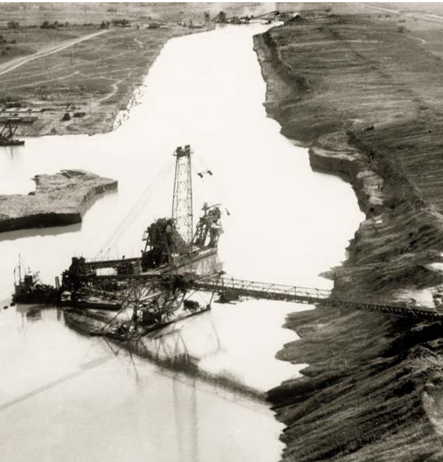
◀ Drague au PK 19. A gauche, souille de lancement des dragues
