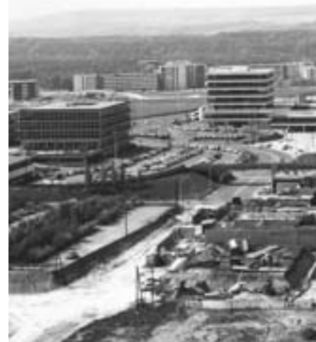
Construction du nouveau centre administratif. (Cergy-Pontoise, opération villes nouvelles MTETM/SG/SIC - 1974 photo Salessé)
