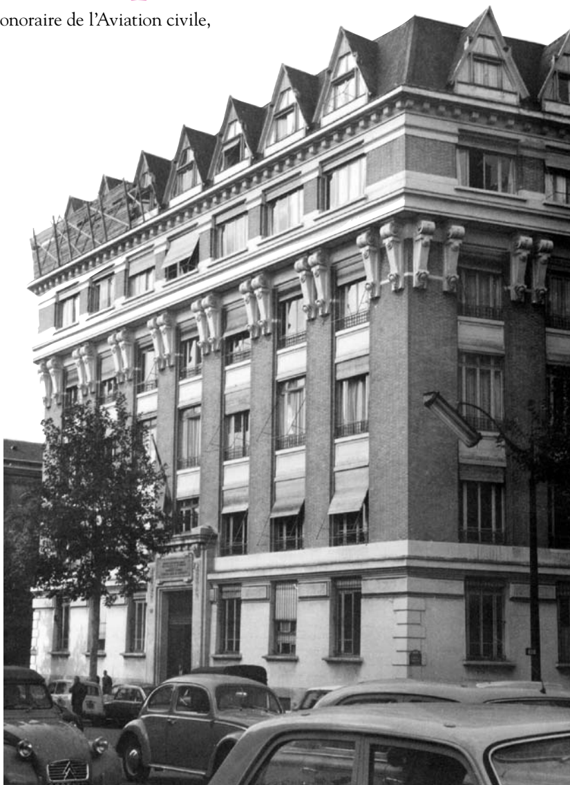
Le fameux immeuble dit « Montparnasse », sis au n° 93 du boulevard du même nom, localisation historique du Secrétariat à l'aviation civile et commerciale (SGACC). MEEDDAT/photothèque STAC ; photo R. Bouvier.
