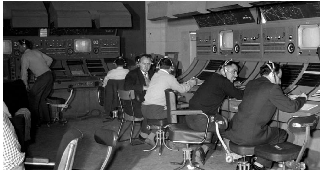
Centre de contrôle en route d'Athis-Mons : salle de contrôle avec opérateurs au travail (1961) MEEDDAT/STAC ; photo R. Bouvier.
