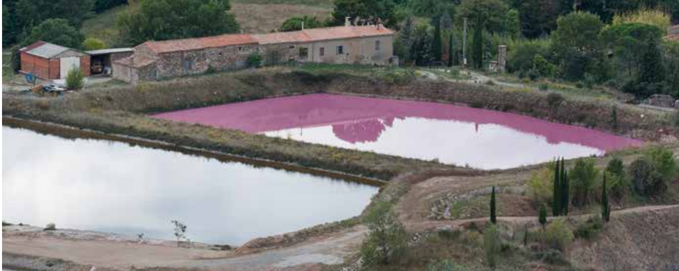
Bassins de récupération des eaux de drainage avant pompage vers la station de traitement sur le stockage réhabilité de l'Artus ©Laurent Mignaux/METL-MEDDE
